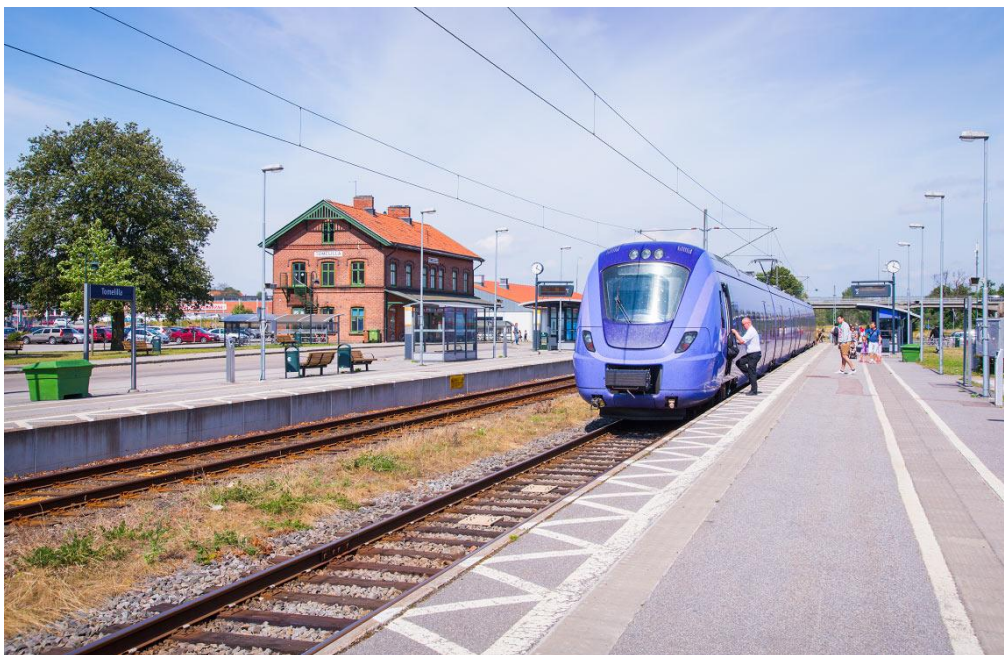
Figur 3-3 Efter elektrifiering och banupprustning. Tomelilla station 2014. Foto: Källa: järnväg.net, foto: Frederik Tellerup
